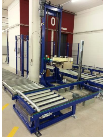
Förderstrecke zum / vom Aufzug
